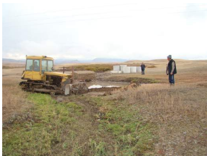
Byggandet av en bro i Kirgizistan. Projektet arbetar också på att locka lantbrukare till avlägsna betesmarker genom att installera grön teknik. Denna utrustning bidrar till att förbättra försörjningen för familjer och herdor som arbetar i avlägsna betesmarker. Foto: UNDP via Flickr CC BY-NC-SA 2.0.
